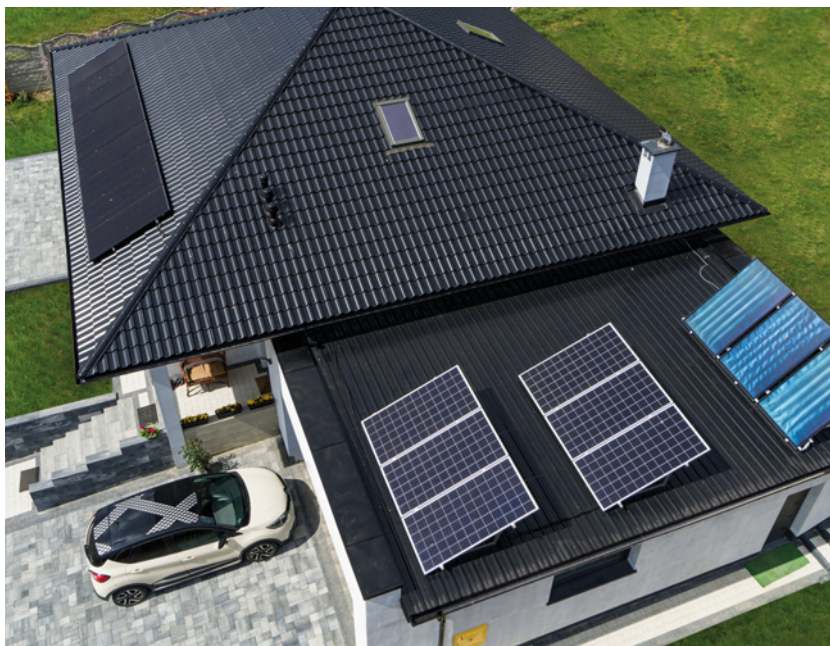
▲ Płaski dach garażu bardzo dobrze nadaje się do ustawienia na nim paneli na stałym nośnym. Wówczas można wybrać najlepszy kąt ich nachylenia. BRUK-BET FOTOWOLTAIKA
