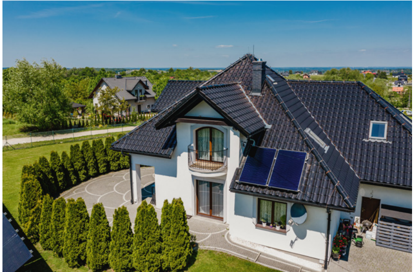
▲ Zwykle w domu jednorodzinnym wystarczają dwa lub trzy kolektory. To niewiele, dlatego nietrudno znaleźć na nie odpowiednie miejsce. HEWALEX
