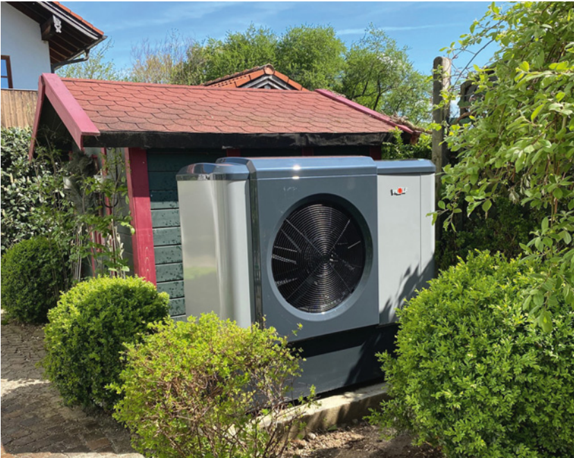
▲ Pompa ciepła działa na zupełnie innej zasadzie niż kocioł, chociaż ostatecznie służy do tego samego celu. Wiele łączy ją natomiast z klimatyzatorami, które są tak naprawdę jedynie szczególnego rodzaju pompami ciepła. WOLF TECHNIKA GRZEWCZA
