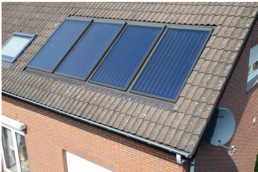
▲ Kolektory można umieścić na pokryciu dachu, lub zintegrować je, zastępując kolektorami część dachówek czy blachy. FAKRO
