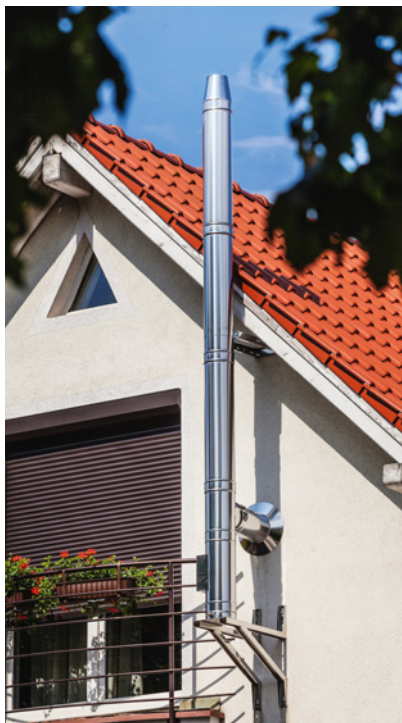
▲ Stalowe kominy prefabrykowane są o wiele lżejsze nie tylko od tradycyjnych wariantów murowanych, ale również od prefabrykowanych modeli ceramicznych. Dlatego zwykle wystarcza zakotwienie ich do ściany. MK ŻARY
