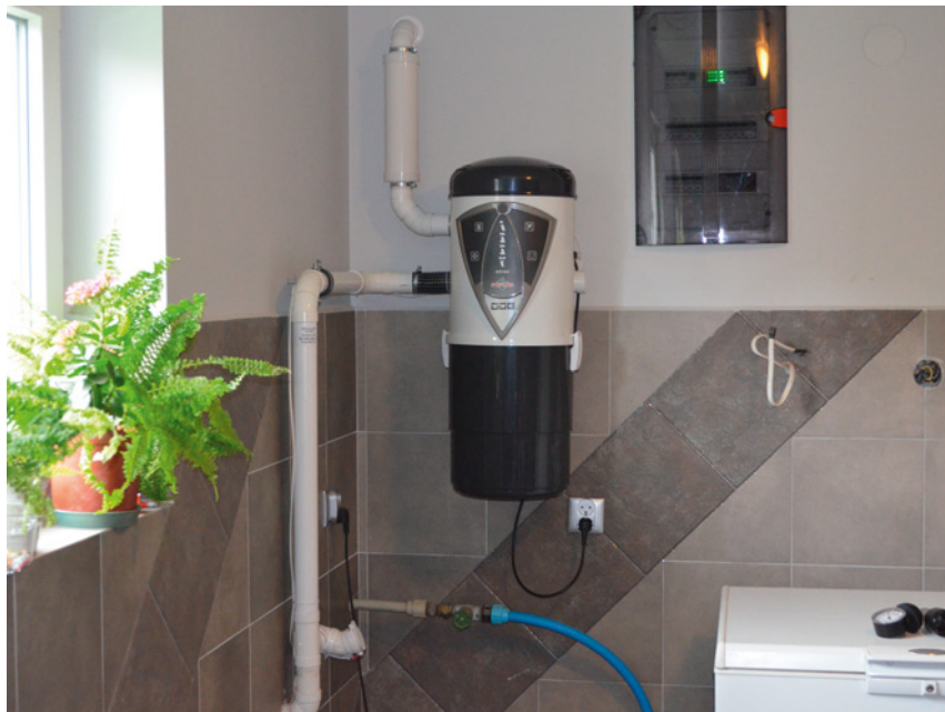
▲Jednostkę centralną, czyli właściwy odkurzacz, najczęściej umieszcza się w pomieszczeniu gospodarczym lub garażu. Chodzi o to, żeby hałas związany z jej pracą nie był uciążliwy dla domowników. ECOMAX
