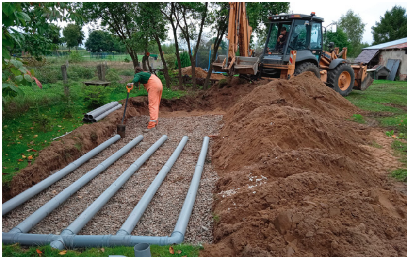
▲ Drenaż służy do rozprowadzenia przynajmniej wstępnie oczyszczonych ścieków. Najlepiej jednak, jeżeli ich rozkład następuje głównie w komorach oczyszczalni. EKO-BIO OCZYSZCZALNIE
