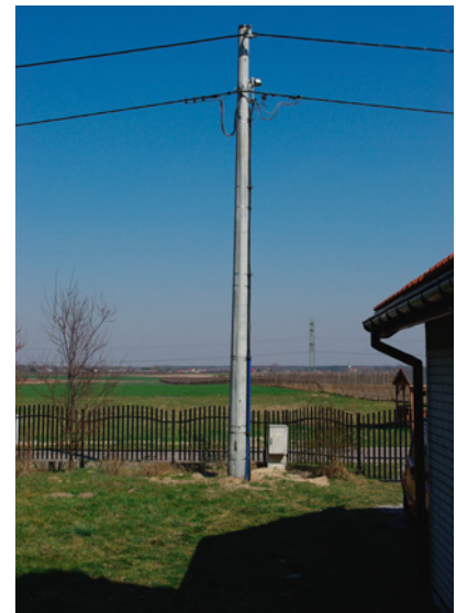
▲ Problemy ze wzrostem napięcia powyżej 253 V zgłaszamy do operatora sieci. Jednak przyczyną kłopotów może być także zły stan domowej instalacji elektrycznej. Jej sprawdzenie też jest konieczne. J. ANTKIEWICZ
