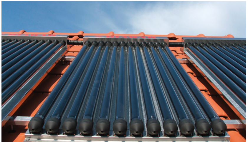
▲ Kolektory próżniowe dają latem nieco mniej ciepła, niż modele płaskie o takiej samej powierzchni. Za to w chłodniejszych porach roku sytuacja się odwraca. NIBE-BIAWAR
