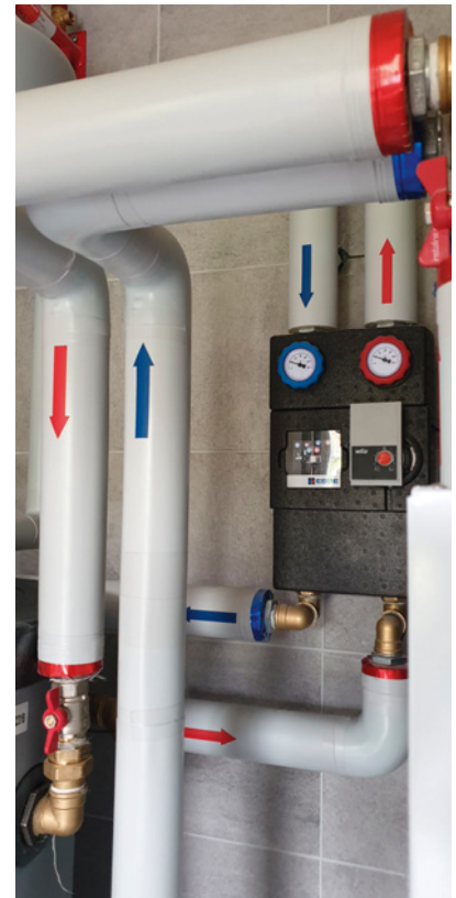
▲ Przepływ wody jest ok. dwa razy większy w układzie z pompą, niż z kotłem. ESBE
