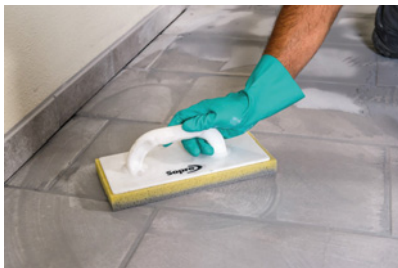
▲ Fugi elastyczne stosuje się na tarasach i balkonach oraz na ogrzewaniu podłogowym. SOPRO
