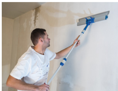
▲ Gładź nanosi się na przegrodę cienką warstwę. Po wstępnym stwardnieniu zwilża się powierzchnię, a następnie ostatecznie ją wygładza. ATLAS
