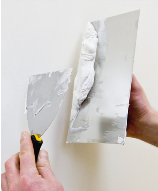
▲ Gładź jest cienką warstwą o grubości nie większej niż 3 mm. Jej nałożenie pozwala uzyskać idealnie gładką powierzchnię. GREINPLAST, ALPOL
