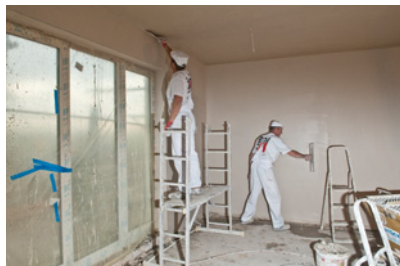
▲ Tynki cementowo-wapienne cechują się dużą wytrzymałością oraz odpornością na zawilgocenie. BAUMIT
