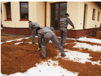
▲ Fachowe wykonanie podbudowy ma ogromne znaczenie dla trwałości tarasu na gruncie. LIBET
