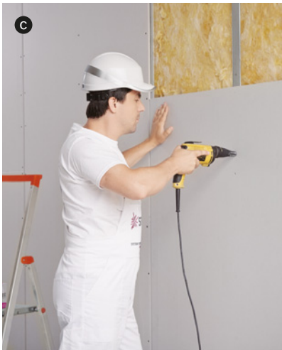
▲ Etapy budowy ścianki szkieletowej: wykonanie konstrukcji z profili (a ROCKWOOL), umieszczenie pomiędzy elementami wełny mineralnej (b PAROC), zamocowanie płyt g-k (c SINIAT), wykończenie połączeń (d DOLINA NIDY).
