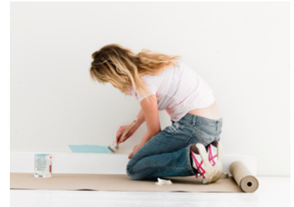
▲ Malowanie ścian zaczyna się za pomocą pędzla od brzegów i trudno dostępnych miejsc. MALFARB
