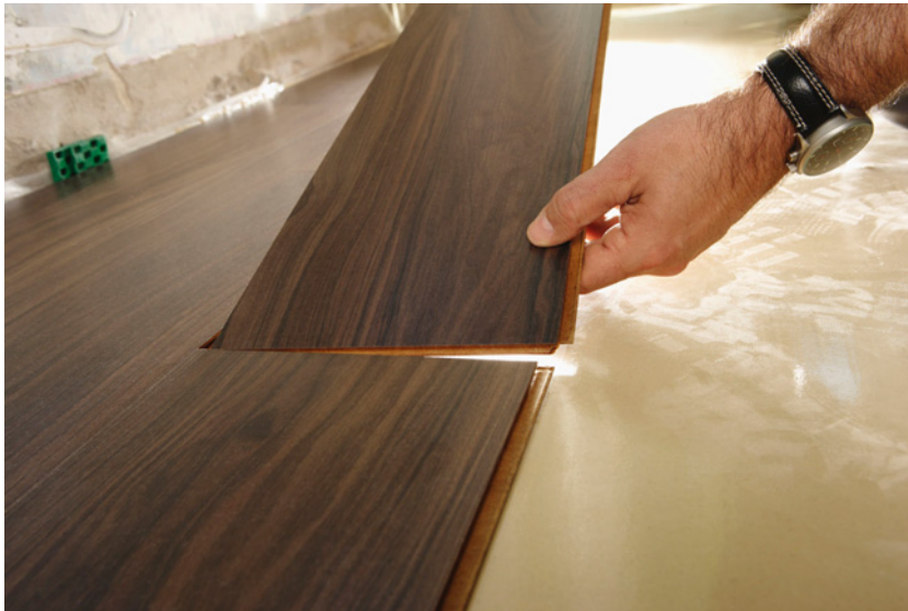
▲ Panele układa się jako podłogę pływającą, zazwyczaj łącząc elementy metodą na pióro i wpust. WINEO
