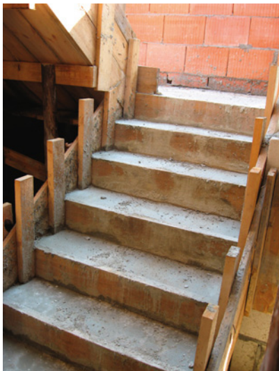
▲ Schody żelbetowe, wylewane w deskowaniu na budowie, od lat cieszą się największą popularnością. M. SZYMANIK
