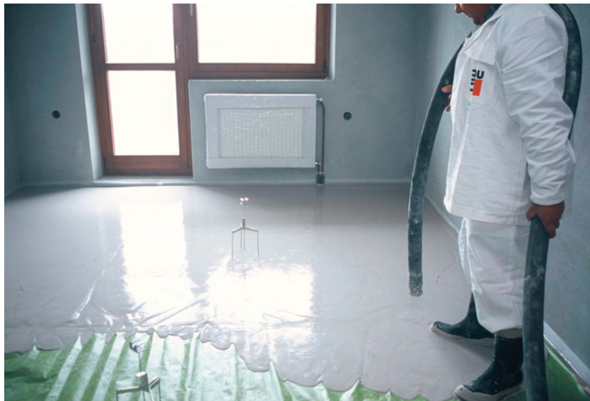
▲ Typowy jastrych, stanowiący podkład posadzki, powinien mieć ok. 5 cm grubości. BAUMIT
