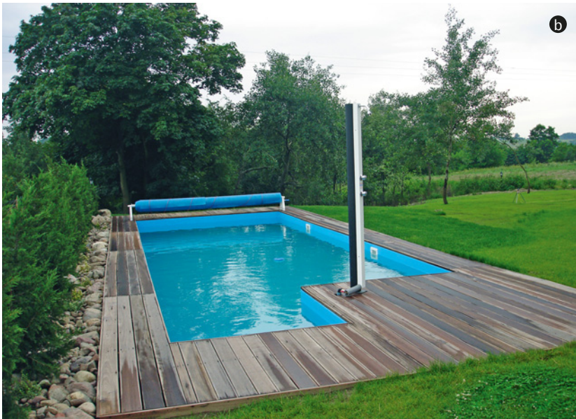
▲ Wykonywanie wykopu pod nieckę (a) i gotowy basen (b). BASENPOOL
