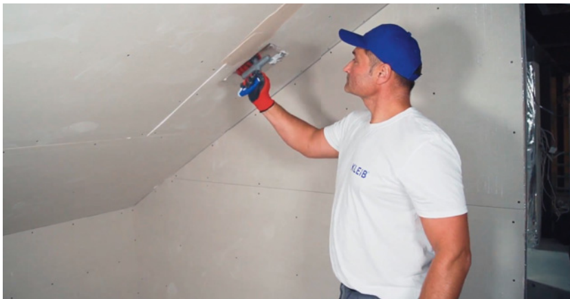
▲ Jednym z zastosowań szpachli jest spoinowanie połączeń i wykańczanie styków płyt g-k. KLEIB
