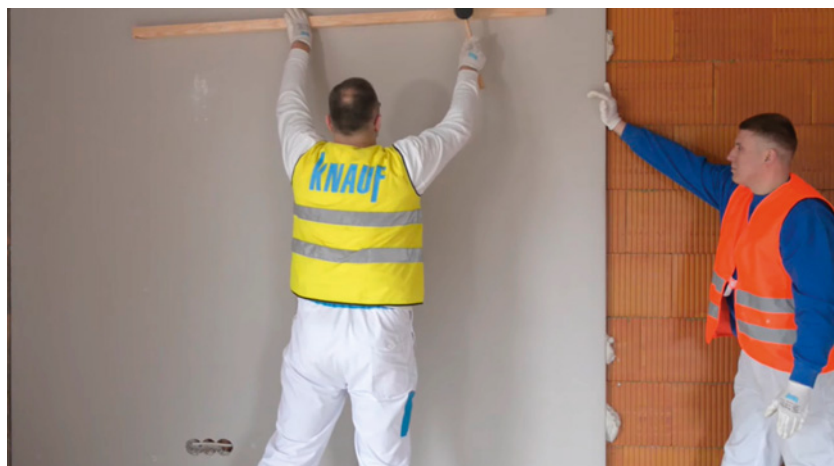
▲ Suchy tynk wykonuje się z płyt g-k. Pozwalają one uzyskać idealnie gładkie ściany, a także przestrzeń, w której można ukryć instalację elektryczną albo cienkie rury. KNAUF
