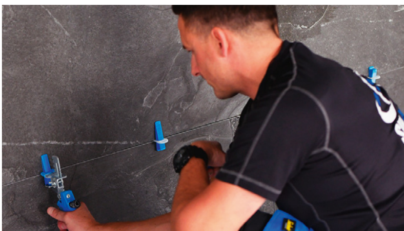
▲ Płytki w bardzo modnych dużych formatach mocuje się na kleje żelowe. KNAUF
