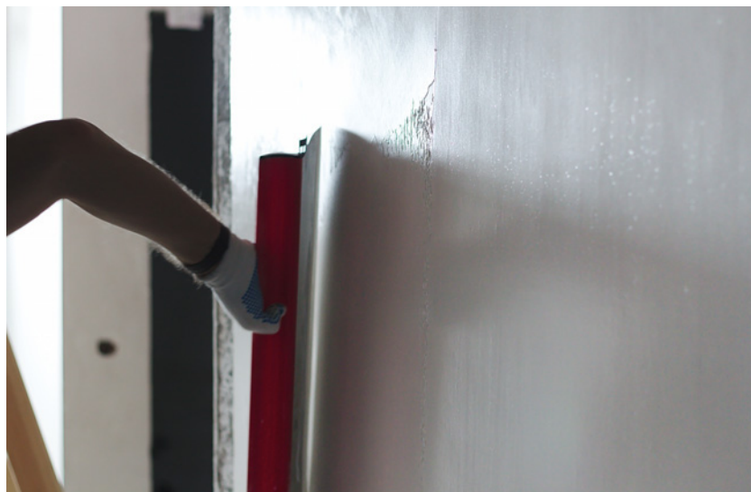
▲ ► Po nałożeniu gładź wygładza się narzędziem nazywanym szpachlą. FRANSPOL
