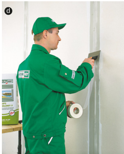
▲ Etapy budowy ścianki szkieletowej: wykonanie konstrukcji z profili (a ROCKWOOL), umieszczenie pomiędzy elementami wełny mineralnej (b PAROC), zamocowanie płyt g-k (c SINIAT), wykończenie połączeń (d DOLINA NIDY).
