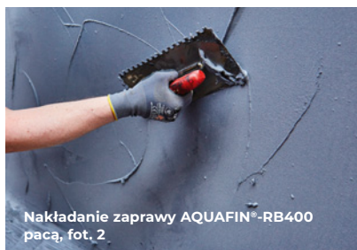
Uszczelnianie elementów budowli stykających się z gruntem
