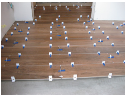
▲ Aby uzyskać odpowiednią szerokość fug, stosuje się specjalne krzyżyki dystansowe. AS
