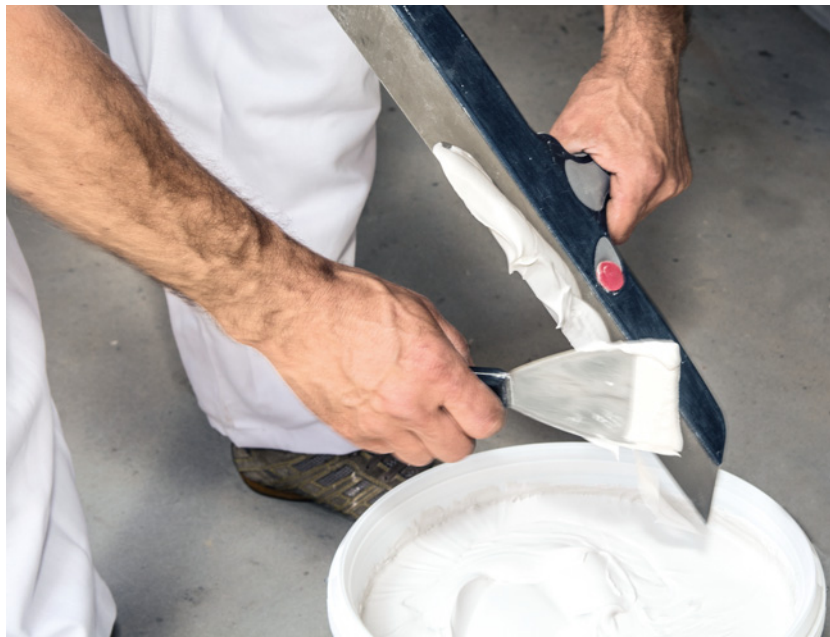
▲ Gładź w wiaderku jest droższa, ale pozwala na przyspieszenie prac. BAUMIT
