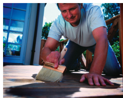
▲ Impregnat należy nanosić długimi, płynnymi ruchami, zgodnie z kierunkiem słoików drewna. BONDEX
