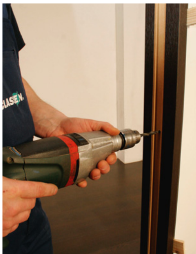
▲ Jeżeli skrzydła są ciężkie, ramę trzeba dodatkowo przytwierdzić za pomocą kołków rozporowych. CLASSEN
