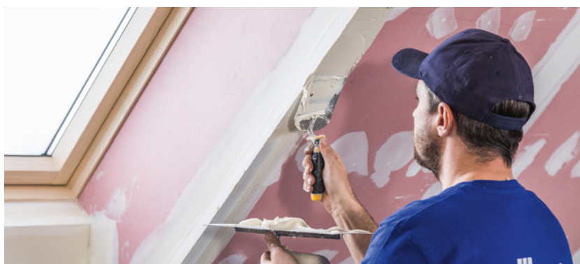
▲ Płyty g-k świetnie nadają się do wykańczania poddaszy. Są niepalne i lekkie, dlatego nie obciążają nadmiernie więźby. SINIAT, RIGIPS
