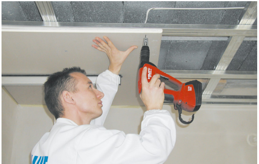
▲ Podwieszany sufit z płyt g-k podtrzymują wieszaki i profile przyściennne UD, które po podklejeniu taśmą przytwierdza się za pomocą kołków. KNAUF
