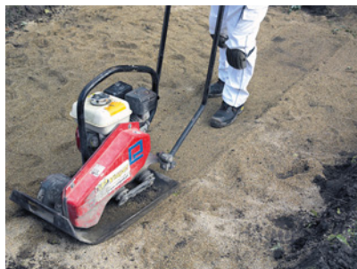
▲ Kolejne warstwy podbudowy nawierzchni powinny być dokładnie zagęszczone. POZBRUK
