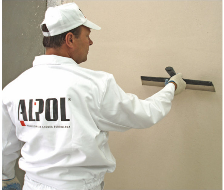
▲ Gładź jest cienką warstwą o grubości nie większej niż 3 mm. Jej nałożenie pozwala uzyskać idealnie gładką powierzchnię. GREINPLAST, ALPOL
