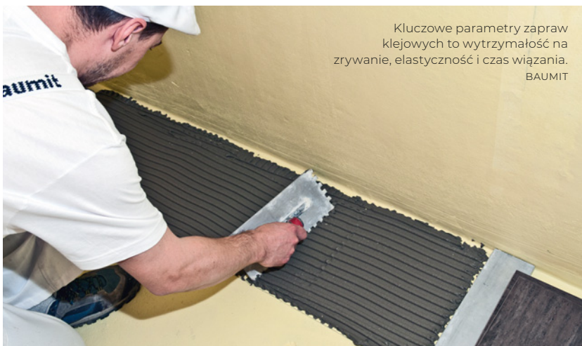
▲ Płytki w bardzo modnych dużych formatach mocuje się na kleje żelowe. KNAUF
