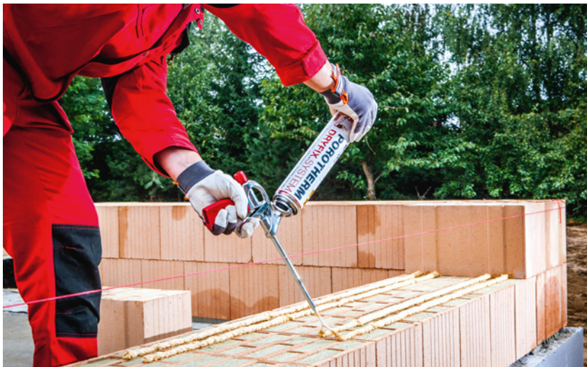
▲ Elementy murowe łączone za pomocą specjalnej pianki. WIENERBERGER
