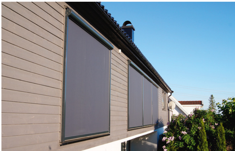
▲ Markizy fasadowe produkowane są z włókna szklanego lub siatki odpornej na czynniki atmosferyczne. AWILUX
