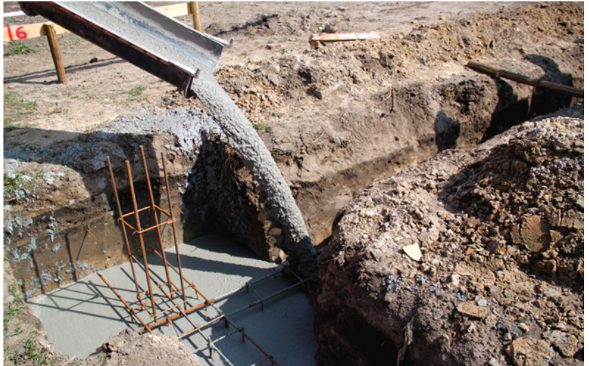
▲ Ława fundamentowa to pozioma belka, najczęściej z betonu wzmocnionego zbrojeniem. Dzięki temu jest odporna zarówno na ściskanie, jak i na rozciąganie. LAFARGE
