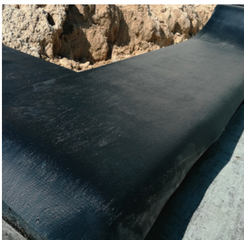
▲ Zabezpieczenie fundamentów i ścian piwnicy folią hydroizolacyjną. WINYL-POL
