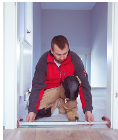
▲ Drzwi wewnętrzne montuje się w otynkowanych już i pomalowanych pomieszczeniach, po ułożeniu posadzek. KAMPANIA EDUKACYJNA „DOBRY MONTAŻ”
