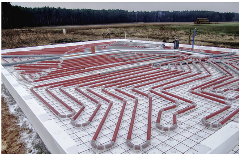
▲ Fundament grzewczy zapewnia równomierne ogrzanie pomieszczeń, bez potrzeby instalowania grzejników. PARATI (LEGALETT)
