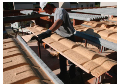
▲ Obecnie najpopularniejszym typem stropu jest konstrukcja gęstożebrowa. RECTOR
