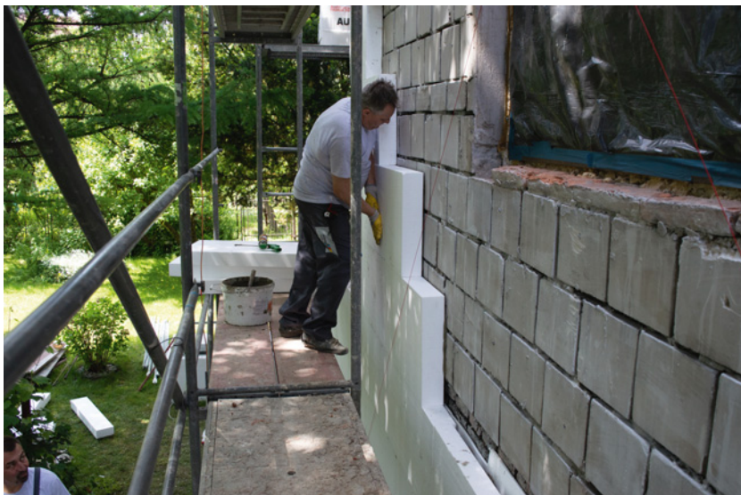
▲ Styropian to najpopularniejszy materiał ociepleniowy w naszym kraju. Większość ścian zaizolowana jest właśnie przy jego użyciu. AUSTROTHERM
