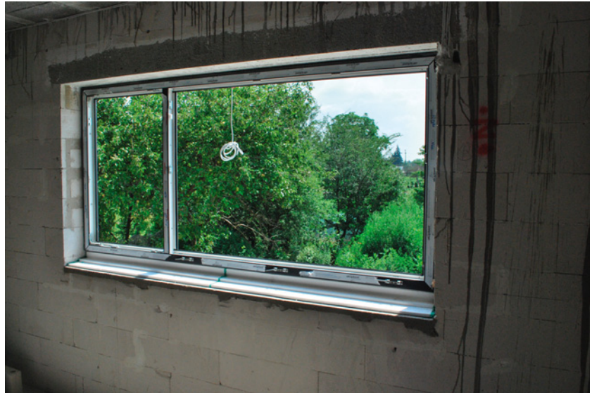
▲ Ciepły parapet eliminuje przedmuchy i mostki termiczne między oknem i parapetem oraz zapobiega powstawaniu zawilgoceń. ALUPLAST
