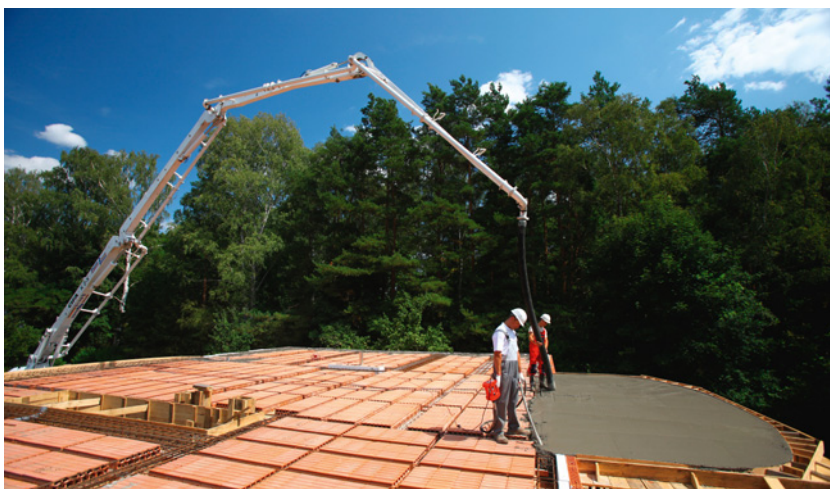
▲ O wyborze rodzaju stropu często decydują ograniczenia wykonawcze, np. to, czy na posesję da się wjechać ciężkim sprzętem. WIENERBERGER
