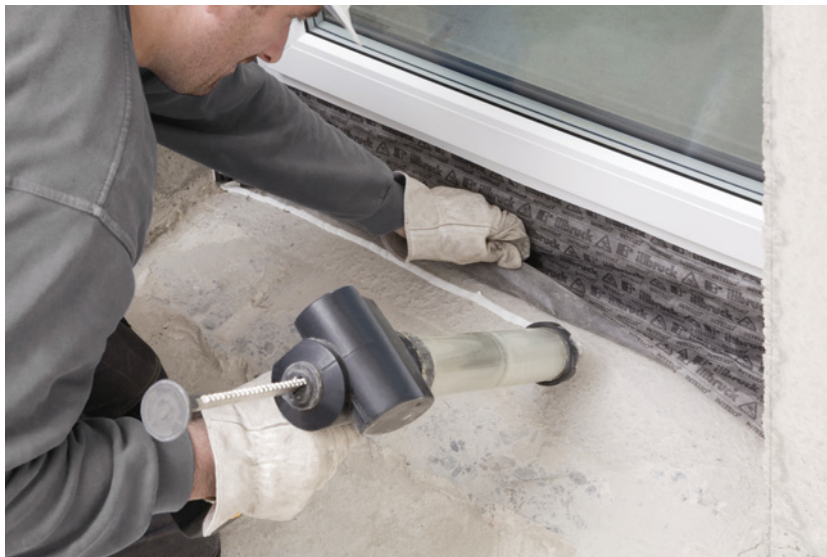
▲ Podłoże, do którego klei się taśmy, powinno być gładkie i oczyszczone. REHAU
