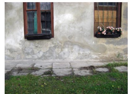
▲ W starych budynkach, w których brakuje poziomej izolacji przeciwwilgociowej fundamentów i podłóg na gruncie, wilgoć może być podciągana z gruntu. ARCHIWUM BD
