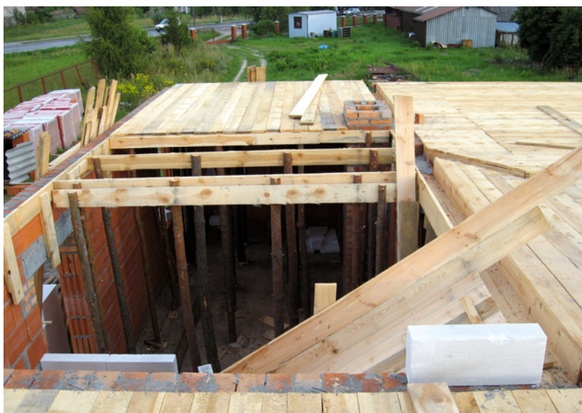
▲ Stropy monolityczne cechują się czasochłonnym montażem. To dlatego, że trzeba wykonać deskowanie i stemplowanie. M. SZYMANIK
