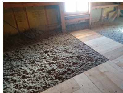
▲ Strop zaizolowany wełną celulozową. 4U IZOLACJE
