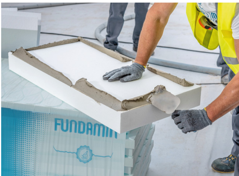
▲ Styropian ma wiele zalet. To materiał dobrze chroniący przed ucieczką ciepła, lekki, łatwy w obróbce oraz odporny na zawilgocenie. STYROPIMIN
