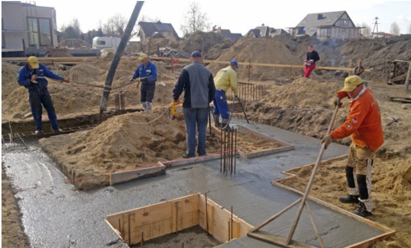
▲ Fundament to kluczowy element konstrukcyjny domu. Jego podstawowym zadaniem jest przekazanie na grunt obciążeń budowli. T. RYBARCZYK
