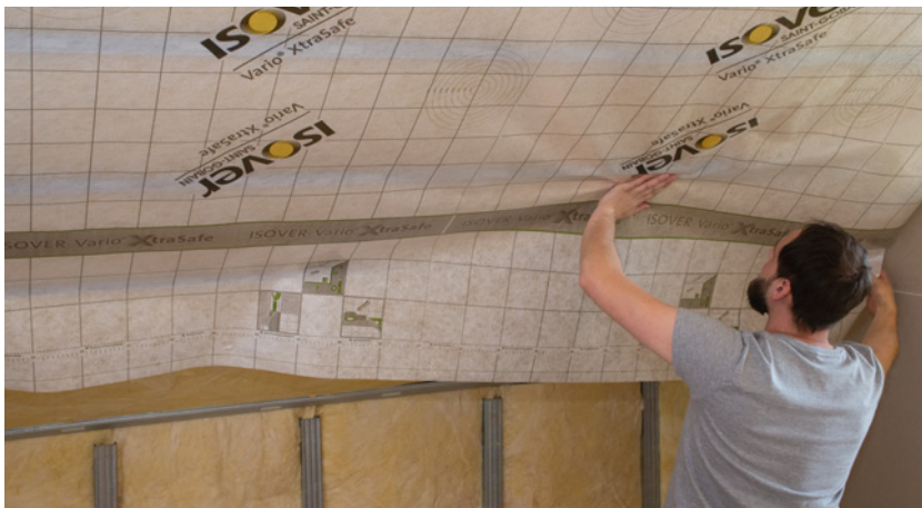
▲ ▼ Konstrukcję dachu rzadko pozostawia się odsoniętą. Zazwyczaj, po ociepleniu wełną, skosy wykańcza się płytami g-k. ISOVER, RIGIPS
