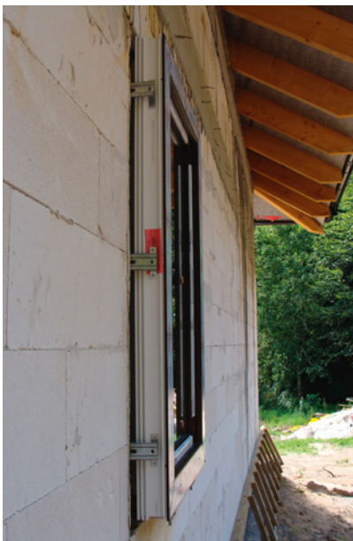
▲ Okno zamontowane przed licem muru na specjalnych wspornikach. ALUPLAST
