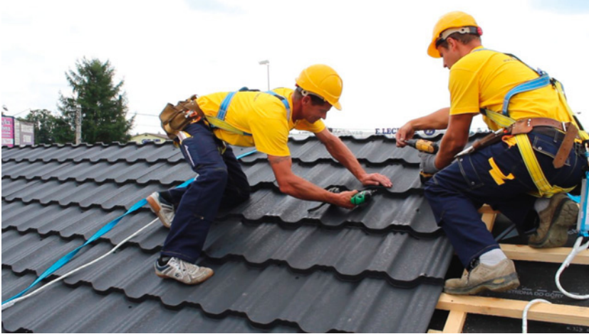
▲ Podczas układania pokryć z blachy trzeba uważać, aby nie uszkodzić powłok ochronnych, bo może to skutkować powstaniem ognisk korozji. BLACHOTRAPEZ
