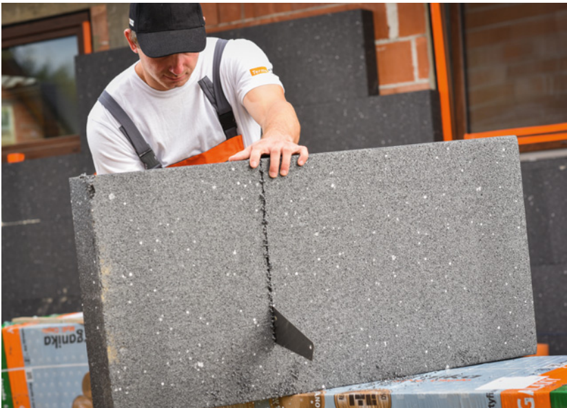
▲ Styropian jest łatwy w obróbce – do cięcia wystarczy zwykła ręczna piła. TERMO ORGANIKA
