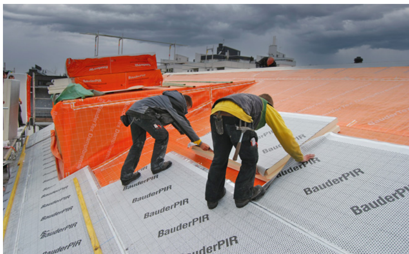
▲ Płyty poliuretanowe mają zastosowanie np. przy ocieplaniu dachu. BAUDER
