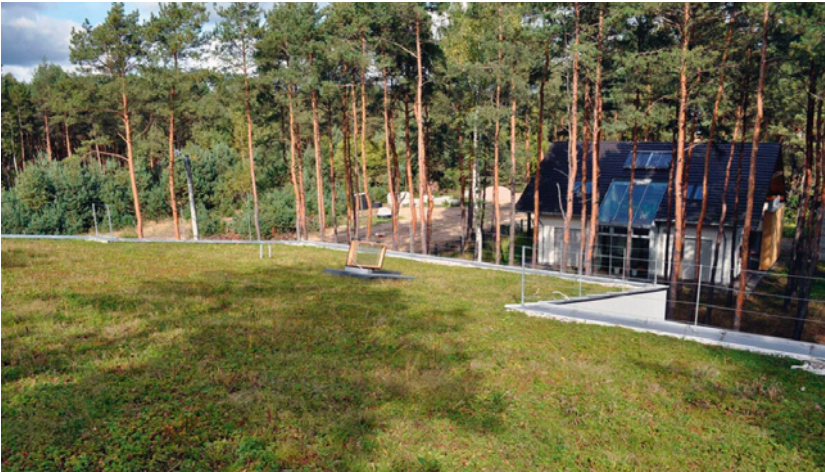
▲ Zielony dach wykonany na dachu płaskim. SOPREMA
