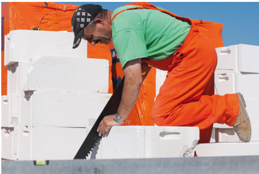
▲ W Polsce najpopularniejsze są technologie murowane, a do wznoszenia ścian używa się najczęściej elementów drobnowymiarowych. TERMALICA (BRUK-BET)
