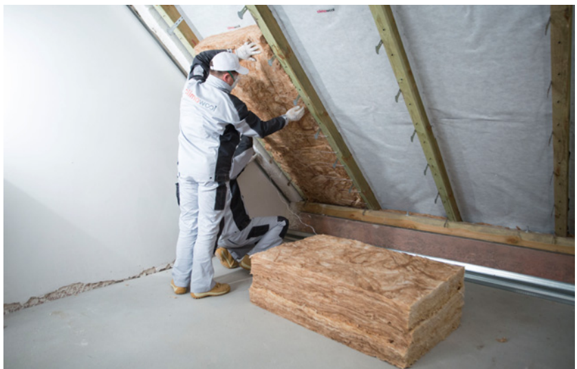
▲ Wełna bardzo dobrze sprawdza się jako izolacja dachów skośnych. Dzięki dużej sprężystości dokładnie wypełnia ocieplaną przestrzeń. CLIMOWOOL
