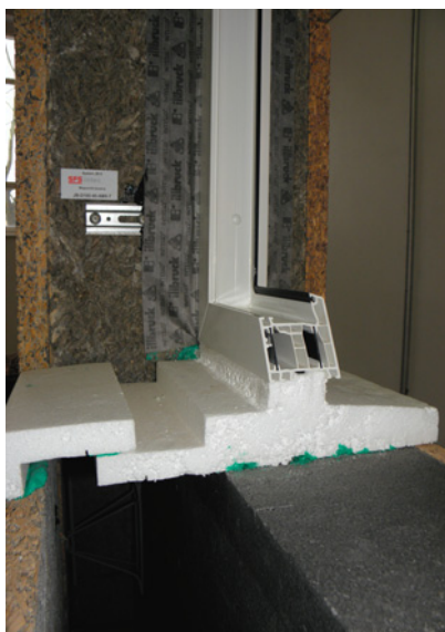
▲ Ciepły parapet to odpowiednio wyprofilowana kształtka z twardego styropianu, która jest oparciem dla parapetu wewnętrznego i zewnętrznego. ALUPLAST
