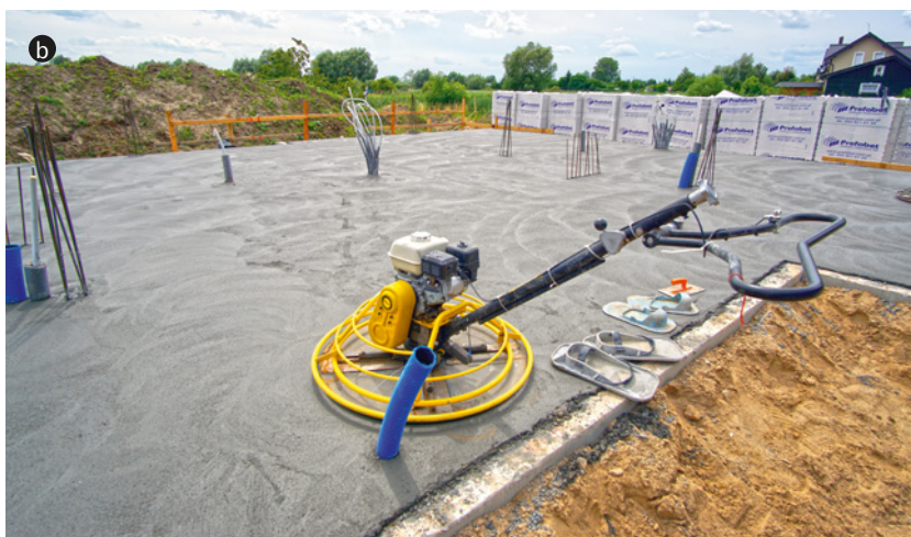
▲ ▼ Ława fundamentowa (a T. RYBARCZYK) czy płyta (b PARATI)? To pierwsze rozwiązanie jest łatwiejsze do wykonania, z kolei płyta lepiej sprawdzi się na działce z gruntem niestabilnym lub o słabej nośności.
