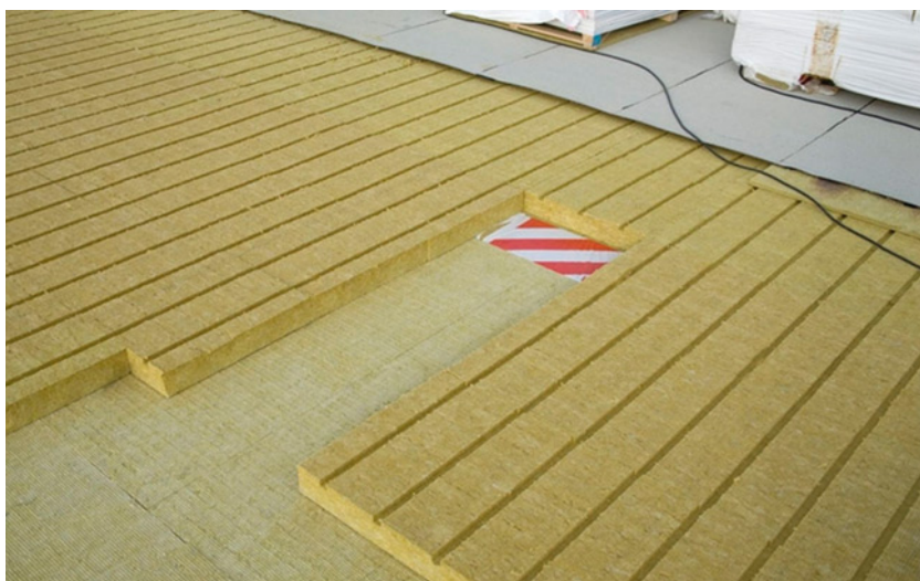
▲ ▼ Do ocieplania dachów płaskich wykorzystuje się zarówno styropian, jak i wełnę mineralną. KNAUF THERM, PAROC
