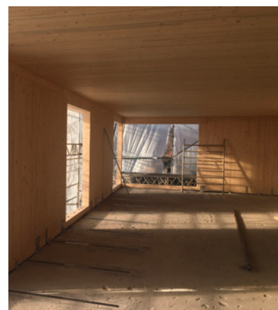
▲ Nadbudowa domu, w którym wszystkie ściany i strop wykonano w technologii drewna klejonego. NORDWOOD
