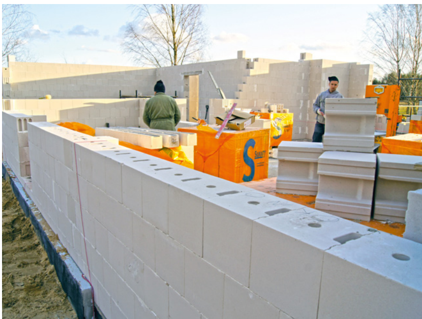
▲ W domu ze ścianami z silikatów jest bardziej stabilna temperatura – wewnątrz wolniej wychładzają się zimą i nagrzewają latem. H+H
