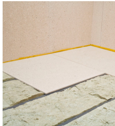
▲ Podłoga ocieplona wełną mineralną. PFLIEDERER
