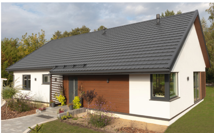
▲ Kształt dachu, kąt nachylenia i kolor pokrycia muszą odpowiadać wymaganiom stawianym przez miejscowy plan zagospodarowania przestrzennego. BLACHY PRUSZYŃSKI, RUUKKI
