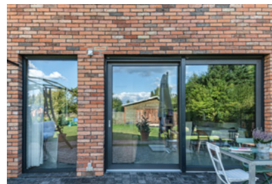
▲ Bezpieczne okna wyposażone są np. w specjalne okucia z zaczepami, wzmocnione profile, szyby laminowane folią czy kłamki z zamkiem. WINKHAUS
