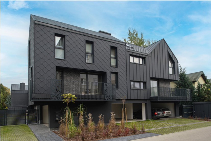
▲ Dach to nie tylko element konstrukcyjny, ale i architektoniczny. Od jego kształtu zależy wygląd budynku. BLACHY PRUSZYŃSKI
