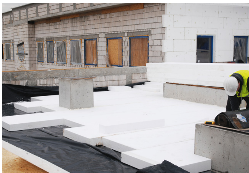
▲ ▼ Do ocieplania dachów płaskich wykorzystuje się zarówno styropian, jak i wełnę mineralną. KNAUF THERM, PAROC
