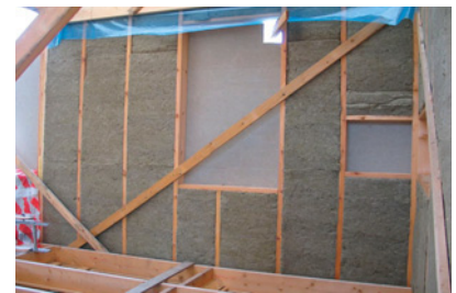
▲ Ściana szkieletowa ocieplona wełną mineralną. PAROC
