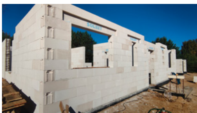
▲ Ściana jednowarstwowa wykonana z użyciem elementów systemowych – ocieplonych nadproży. SOLBET
