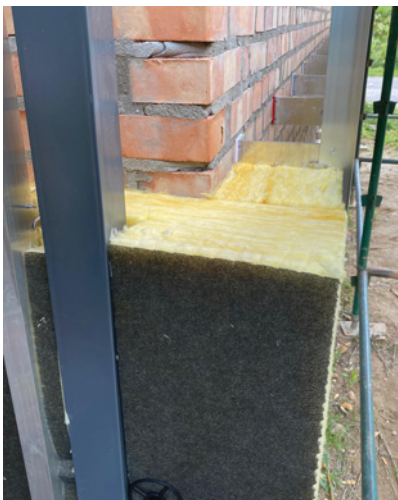
▲ Typowa grubość wełny w ścianach dwuwarstwowych to 15–25 cm. URSA
