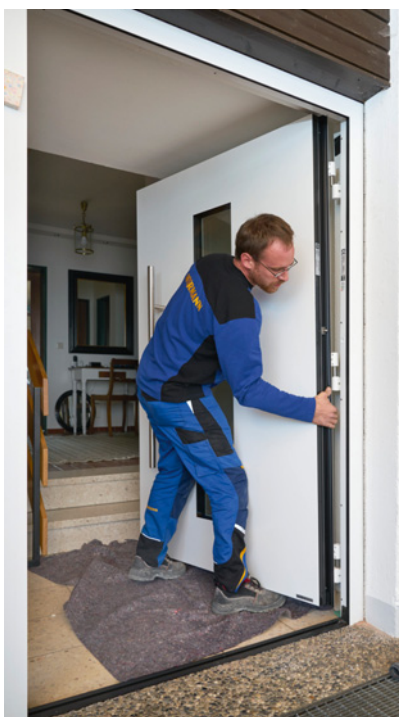
▲ Drzwi wejściowe najlepiej zamontować po ułożeniu posadzek i pomalowaniu wewnątrz, aby podczas prac wykończeniowych nie doszło do ich uszkodzenia. HÖRMANN
