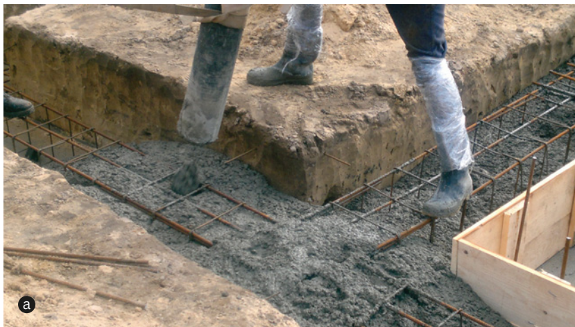
▲ ▼ Ława fundamentowa (a T. RYBARCZYK) czy płyta (b PARATI)? To pierwsze rozwiązanie jest łatwiejsze do wykonania, z kolei płyta lepiej sprawdzi się na działce z gruntem niestabilnym lub o słabej nośności.
