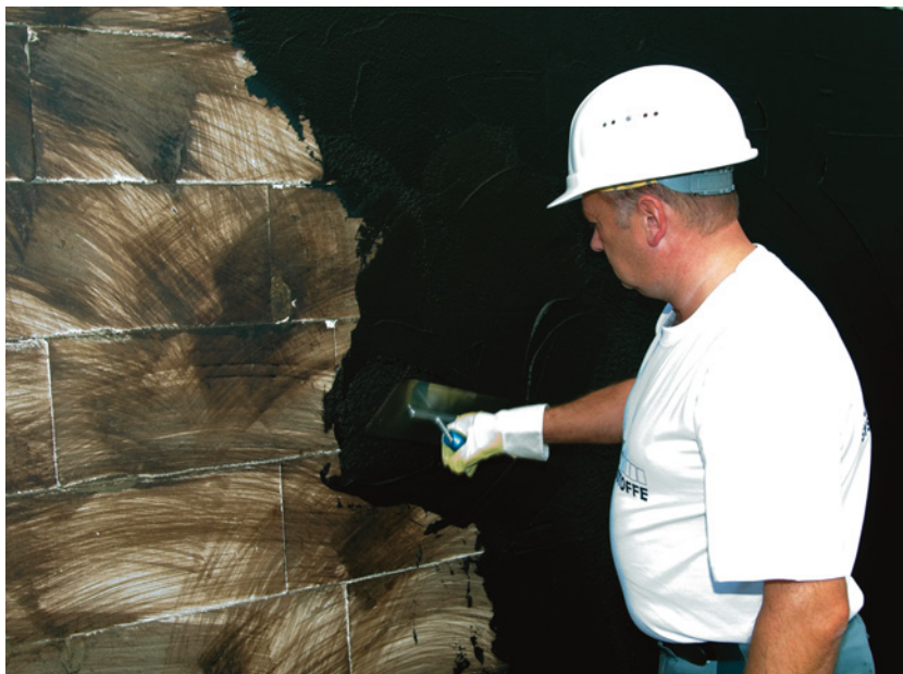
▲ Fundamenty muszą być zabezpieczone przed wilgocią, która jest bardzo groźna dla konstrukcji budynku. BOTAMENT
