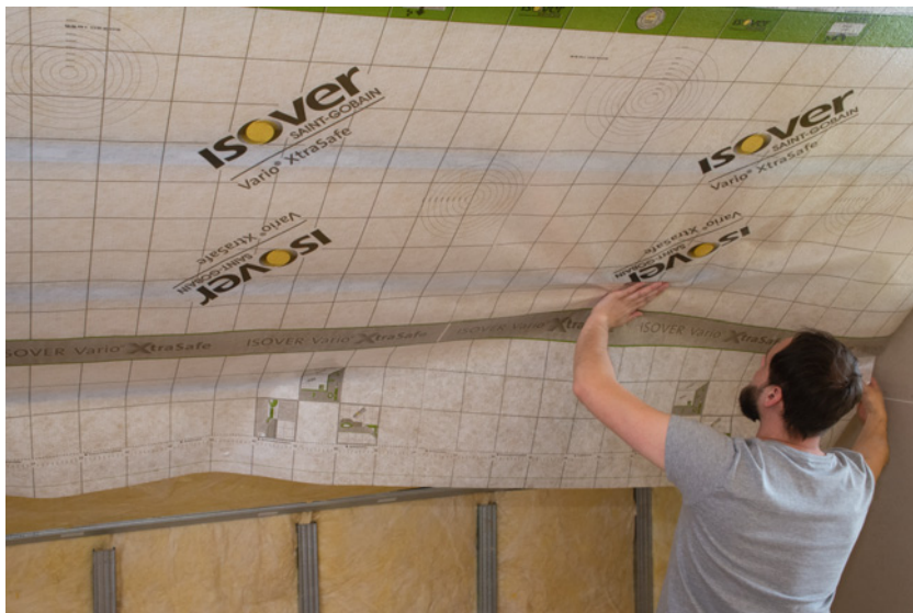
▲ Wełna zamocowana do spodu dachu musi być szczelnie pokryta folią paroszczelną. Materiał ten zapobiega kondensacji pary wodnej w warstwie ocieplającej i chroni konstrukcję dachu przed zawilgoceniem. ISOVER
