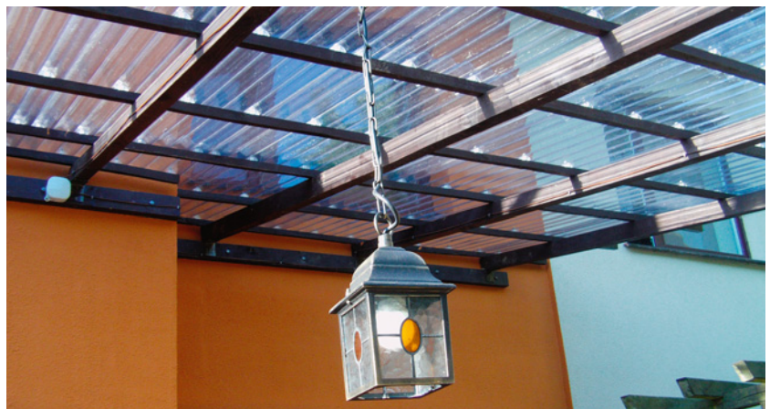
▲ Zadaszenie z przezroczystego materiału zapewnia ochronę przed deszczem, a jednocześnie pozwala doświetlić taras. ROBELIT
