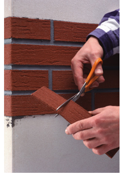
▲ Montaż płytek elewacyjnych imitujących cegłę. IZOFLIX
