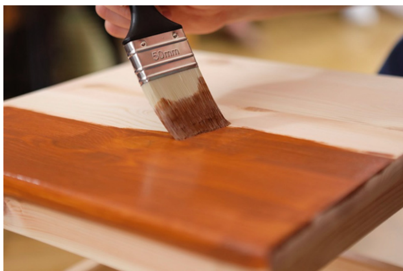
▲ Większość preparatów zabezpieczających drewno nanosi się miękkim pędzlem. REMMERS, DRAGON
