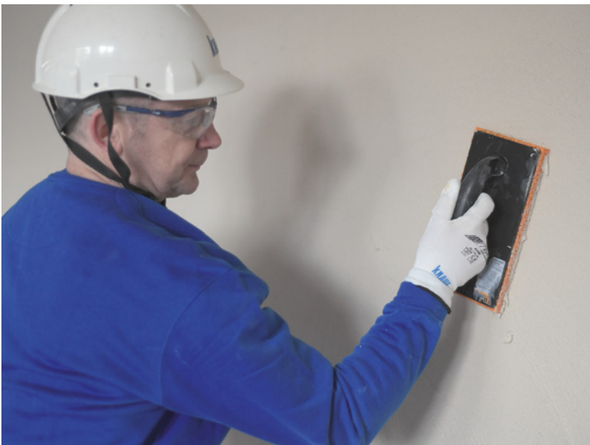
▲ Gładzie gipsowe nie powinny być stosowane tam, gdzie wilgotność powietrza utrzymuje się powyżej 70%. Takich obostrzeń nie ma w przypadku wyrobów polimerowych i cementowych. KNAUF
