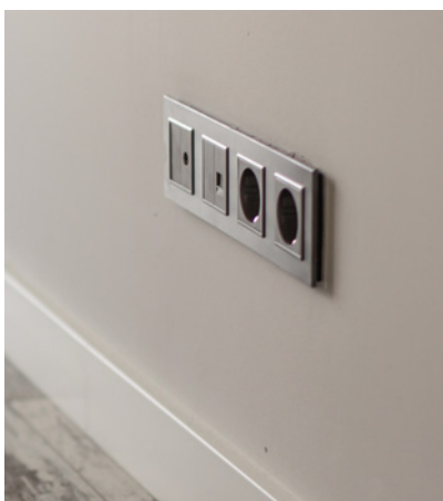
▲ ► Gniazda w pokojach montuje się zazwyczaj na wysokości ok. 30 cm od posadzki, natomiast w kuchni i łazience – 110–120 cm. LIVOLO
