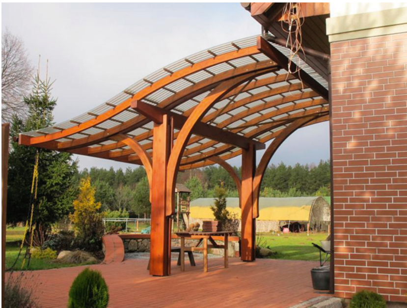
▲ Zadaszenie wykonane na efektownej drewnianej konstrukcji. JAGRAM-PRO
