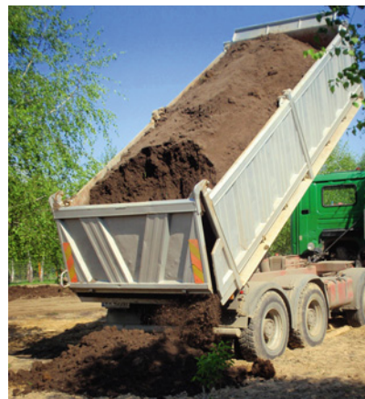
▲ Prace ziemne to pierwszy etap urządzania ogrodu. WWW.SORTEDWAW.PL
