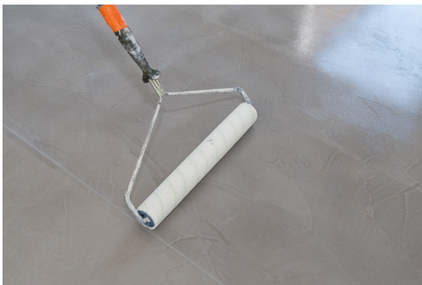
▲ Technologia wykonania podłogi zależy m.in. od tego, w jakim miejscu się ona znajduje. WEBER (SAINT GOBAIN)
