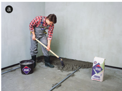
▲ Do wyboru są trzy rodzaje jastrychu: cementowy (a ATLAS), anhydrytowy (b LAFARGE) i suchy (c KRONOPOL).
