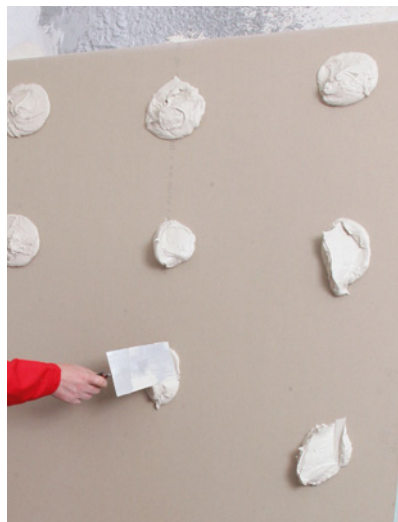
▲ Klej nakłada się na płyty w plackach, rozmieszczonych regularnie na całej powierzchni. CEKOL (CEDAT)
