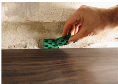
▲ Panele układa się jako tzw. podłogę pływającą, która nie jest trwale związana ze ścianami. WINEO
