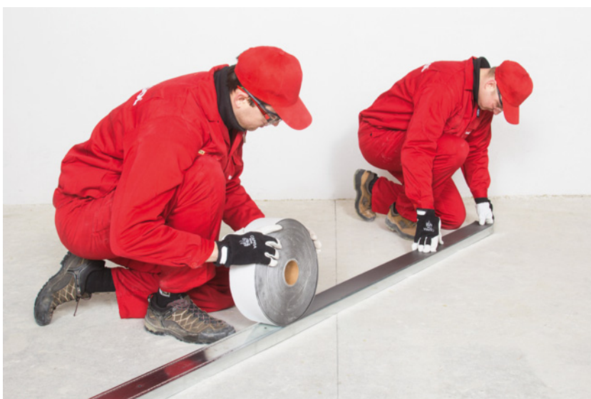
▲ Profile obwodowe podkleja się taśmą, która tłumi dźwięki i drgania. ROCKWOOL
