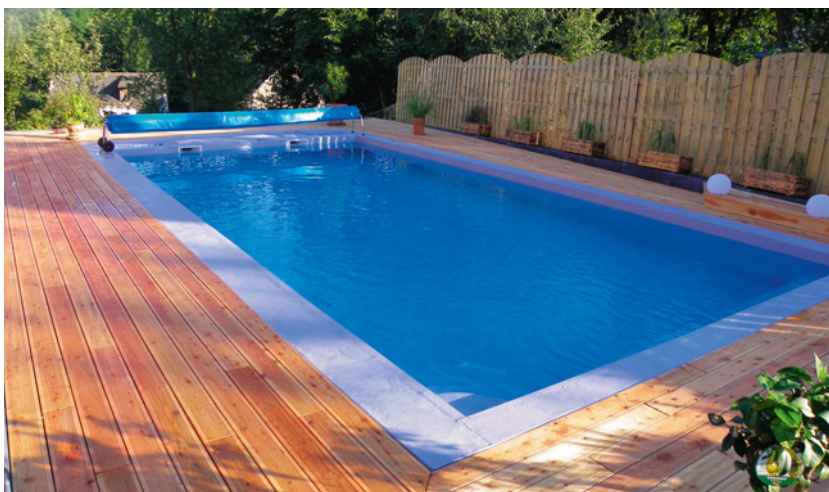
▲ Nawierzchnia wokół basenu powinna być wykonana z antypoślizgowych materiałów. POLDER, JAF POLSKA
