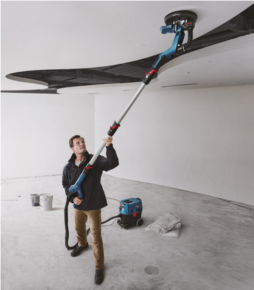
▲ Gładź wyrównuje się specjalną maszyną na wysięgniku, tzw. żyrafą. BOSCH
