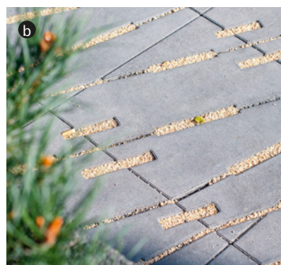
▲ Bruk ekologiczny może mieć wypusty dystansowe (a SEMMELROCK) lub otwory (b POLBRUK).
