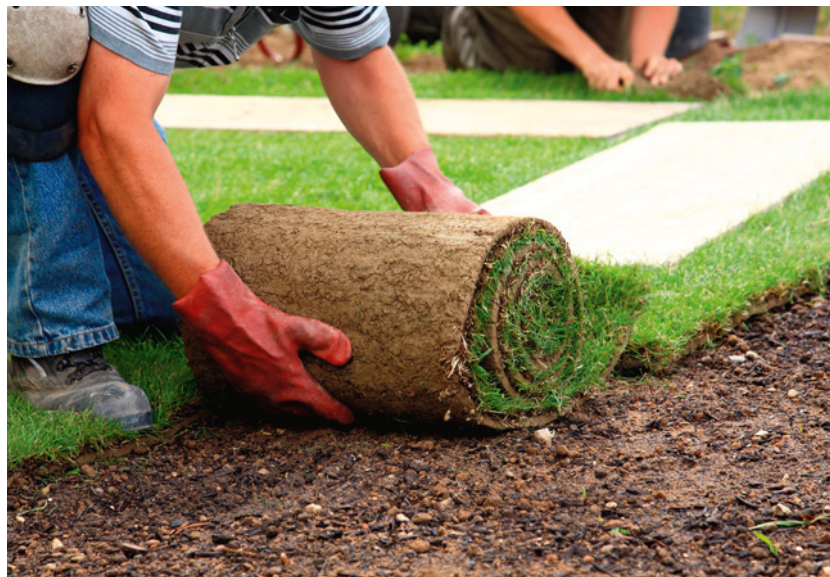
▲ Układ płyt darni powinien przypominać ułożenie cegieł w murze. Zewnętrzne elementy należy dociąć nożem tak, aby nie wystawały poza obrys trawnika. DREAMSTIME
