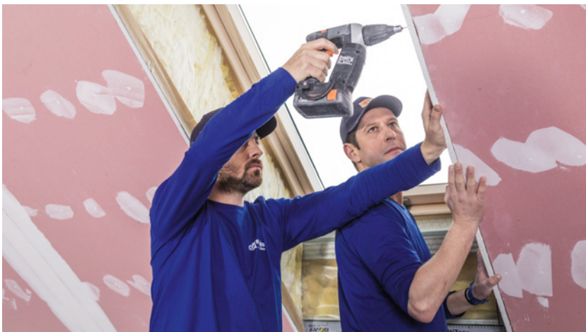
▲ ▼ Do mocowania płyt wykorzystuje się blachowkręty. RIGIPS, SINIAT
