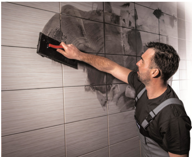
▲ Fugę dobiera się biorąc pod uwagę przede wszystkim dwa elementy – warunki, w jakich będą pracować, a także rodzaj płytek. CERESIT
