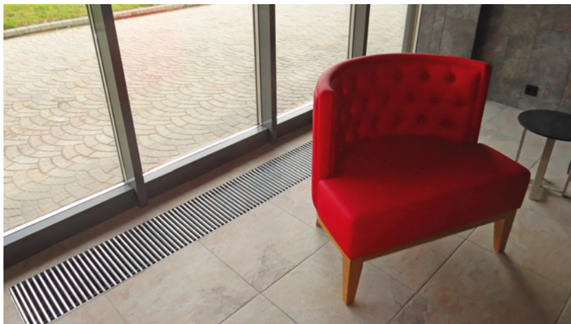
▲ Grzejniki kanałowe najczęściej montuje się w pomieszczeniach, w których ściany zewnętrzne są przeszklone. VERANO
