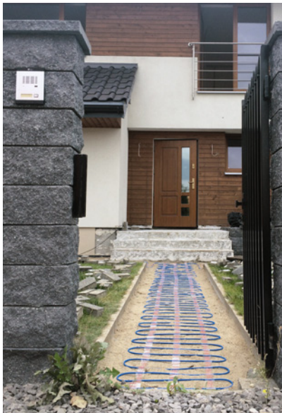
▲ O systemie przeciwołobdzeniowym na ścieżkach prowadzących do wyjścia najlepiej pomyśleć wtedy, gdy robimy nawierzchnię. NVENT RAYCHEM
