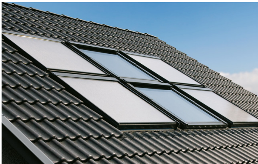
▲ Kolektory mają spory wpływ na wygląd domu, dlatego warto je zgrupować wraz z oknami dachowymi. FAKRO
