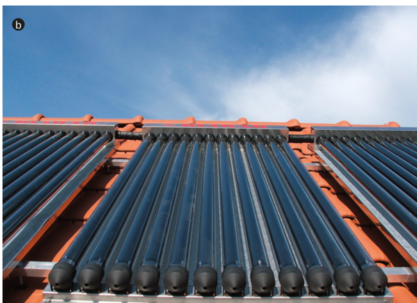
▲ Dwa najpopularniejsze typy kolektorów słonecznych – płaski (a GALMET) i próżniowy rurowy (b NIBE-BIAWAR).
