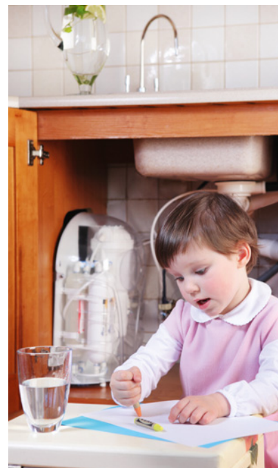
▲ Filtr wykorzystujący zjawisko odwróconej osmozy jest najdokładniejszy, ale oczyszczoną w ten sposób wodę trzeba mineralizować. USTM
