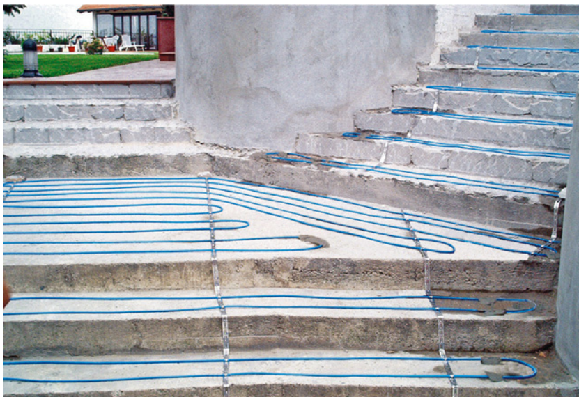
▲ Przewody grzewcze na schodach zewnętrznych układa się wzdłuż stopni w odstępie 7–8 cm. Kable nie mogą nachodzić na siebie ani się krzyżować. ELEKTRA
