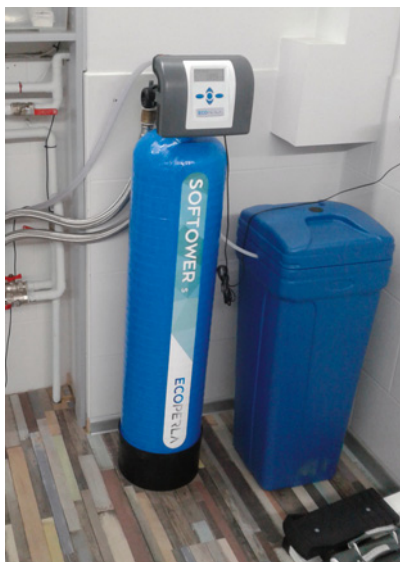
▲ W domach z wodą ze studni do uzdatniania potrzebne są znacznie większe urządzenia, np. taki zmiękczac. KLARSAN nie to usuwanie z wody niepożądanych substancji. Tę z wodociągu przeważnie tylko nieco doczyszczamy, żeby poprawić jej smak, zapach, czy ją zmiękczyć. Jej dostawca zobowiązany jest bowiem do regularnego badania jakości i dostarczania odbiorcom produktu zdatnego do picia. Przy własnym ujęciu sprawa jest bardziej skomplikowana. Zacząć trzeba od zbadania składu wody w stacji sanepidu lub prywatnym laboratorium i w zależno-
