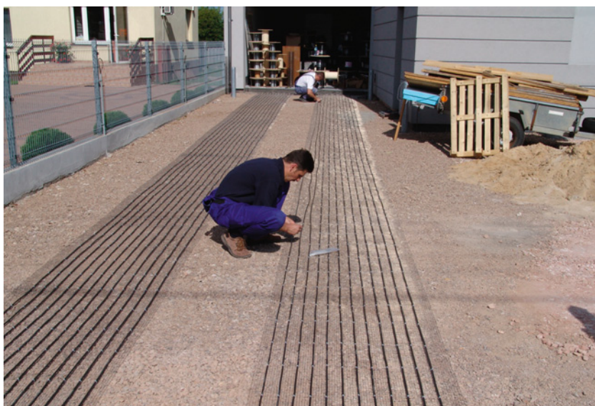
▲ Instalacja przeciwołodziennic świetnie sprawdza się na posesji – na podjeździe do garażu i na traktach pieszych. FENIX POLSKA
