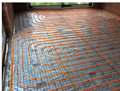
▲ Modele kondensacyjne pracują najefektywniej w połączeniu z niskotemperaturowym ogrzewaniem podłogowym. RWC
