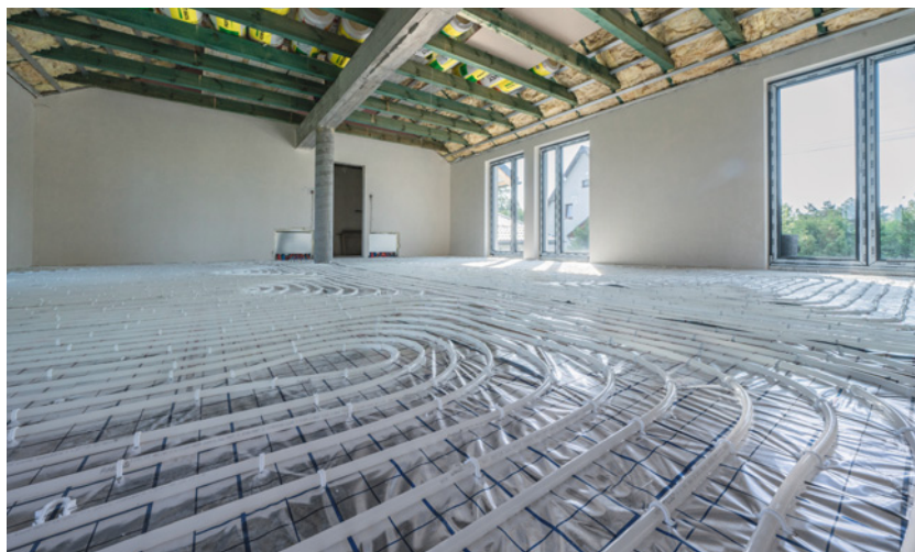
▲ Jak najniższa temperatura wody w instalacji grzewczej to wysoka sprawność pompy. Dlatego zalecane jest niskotemperaturowe ogrzewanie podłogowe. PIPELIFE
