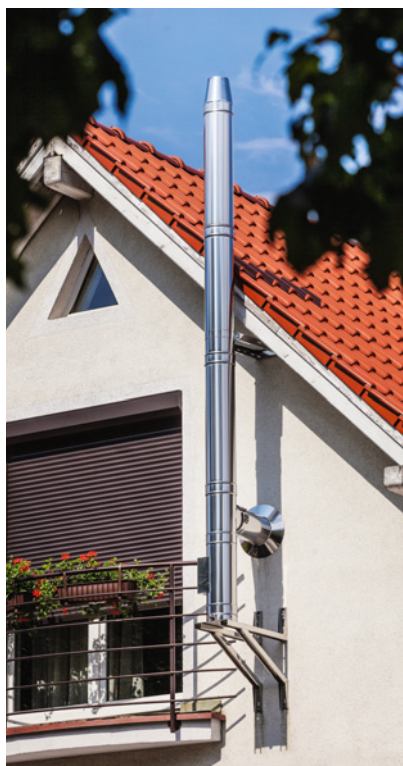
▲ Kominy zewnętrzne wykonuje się zazwyczaj podczas remontów, gdy niemożliwe jest przebicie się przez stropy i dach, lub gdy takie przedsięwzięcie wiązałoby się z dużymi kosztami i nakładem pracy. MK ŻARY
