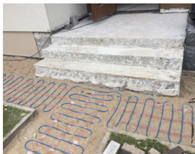
▲ Przewody grzejne na podjazdach i chodnikach wyłożonych kostką układamy w warstwie piaskowo-cementowej. Bardzo ważna jest moc przewodu – im jest niższa, tym przewód powinien być bliżej nawierzchni. NVENT RAYCHEM
