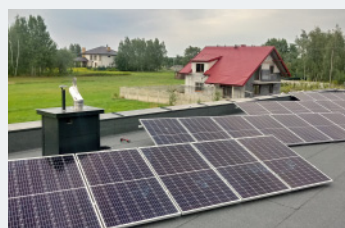
🔧 Do dachu umocowano dyblami 27 ogniw fotowoltaicznych.
