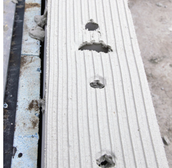
🔧 Bloczki silikatowe cechuje duża dokładność wymiarowa, można je więc murować na cienkowarstwowe zaprawy klejowe. J. WERNER
