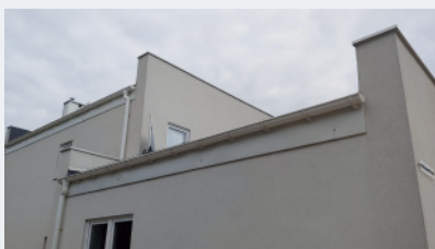
Dachy ocieplono płytami PUR i wykończono papą.
