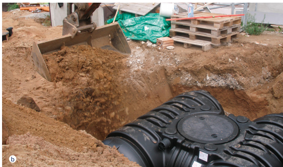
Osadzanie podziemnego zbiornika na wodę wykonanego z betonu (a gizo) i zasypywanie modelu z tworzywa (b ROTH POLSKA).
