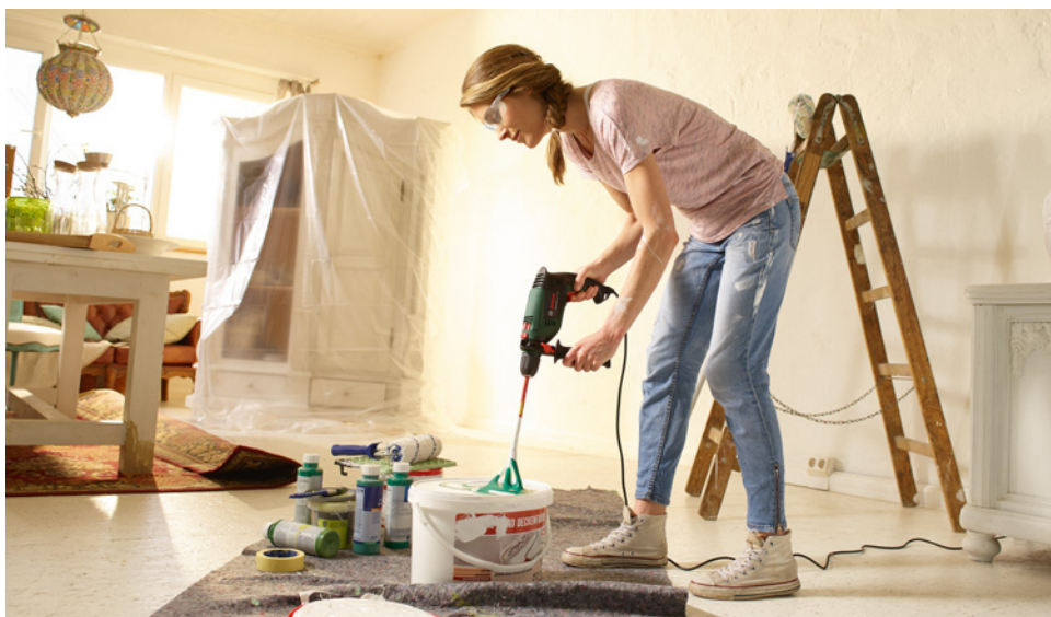
🔧 Wiertarka ze specjalną końcówką pozwala mieszać różne zaprawy klejowe. BOSCH
