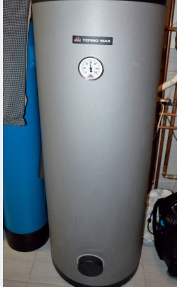
❷ Stojący zasobnik c.w.u. o pojemności 145 l.
