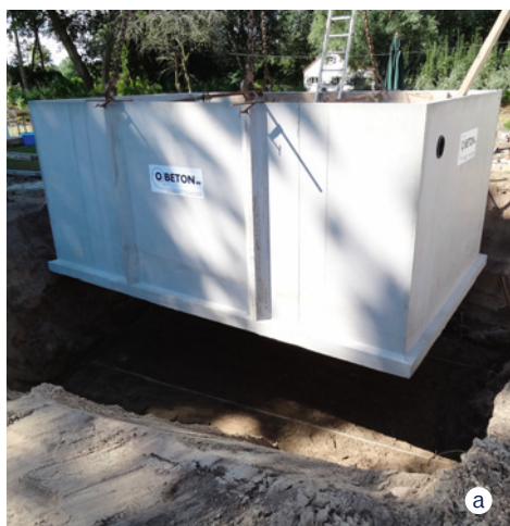
Osadzanie podziemnego zbiornika na wodę wykonanego z betonu (a gizo) i zasypywanie modelu z tworzywa (b ROTH POLSKA).
