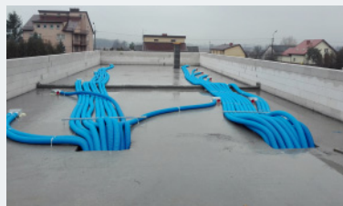
🔧 Przez otwory w żelbetowym stropodachu wyprowadzono rury wentylacji mechanicznej.
