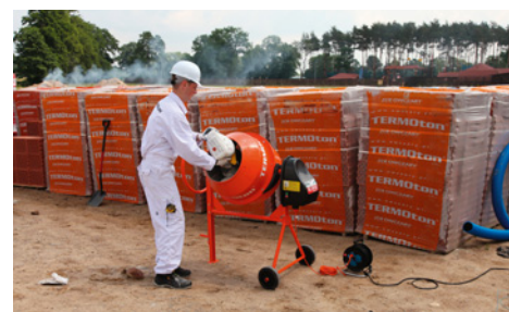
❶ Mur to nie tylko pustaki i bloczki, ale także zaprawa. Tradycyjnie rozrabia się ją w betoniarnie. ZCB OWCZARY
