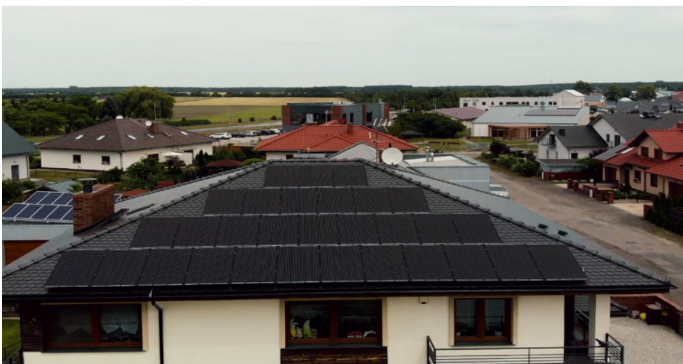
📍 Pamiętajmy, że to nie same panele, ale promieniowanie słoneczne jest źródłem energii w instalacji PV. Dlatego ich właściwe ustawienie jest tak ważne. BRUK-BET FOTOWOLTAIKA
