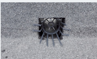
🔧 W 5 otworach w attyce przytwierdzono 5 wpustów attykowych i połączono z rurami spustowymi (w elewacji).
