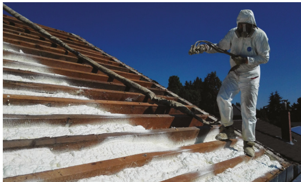
🔥 Otwartokomórkowa pianka PUR jest materiałem paroprzepuszczalnym. Jednak nie wolno jej nakładać na zawilgoconą więźbę. SOUDAL
