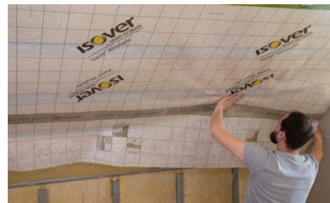
❷ Po ułożeniu wełny trzeba zamocować paroizolację, która będzie chronić ocieplenie przed kondensacją pary wodnej gromadzącej się na poddaszu. ISOVER
