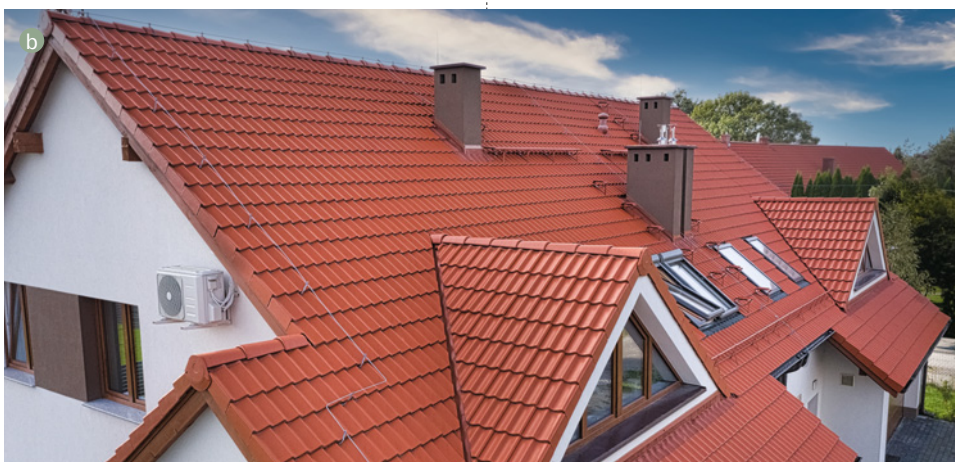
📌 Klasyczna czerwień z różnych i odmiennie wykończonych materiałów: dachówka ceramiczna angobowana (a WIENERBERGER) i cementowa z błyszczącą powierzchnią (b CREATON POLSKA).
