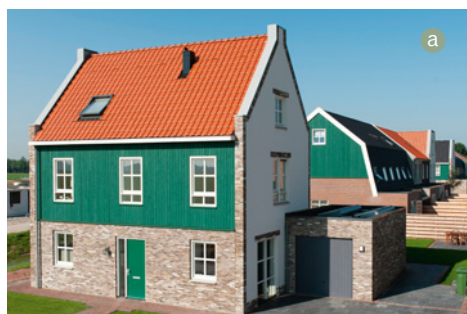
📌 Klasyczna czerwień z różnych i odmiennie wykończonych materiałów: dachówka ceramiczna angobowana (a WIENERBERGER) i cementowa z błyszczącą powierzchnią (b CREATON POLSKA).
