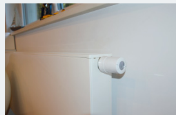
❹ Grzejnik z automatyczną głowicą sterującą.
