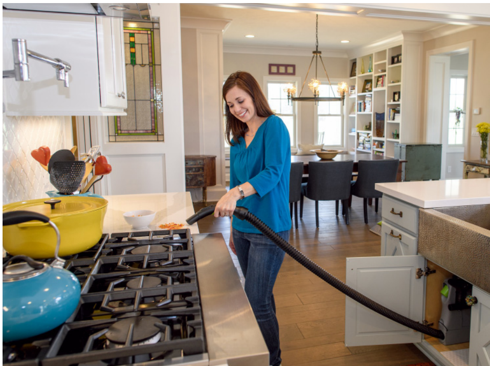
Gniazdo z węzem rozciąganym do kilku metrów. Zamontowanie takiej wersji w szafce kuchennej znacznie ułatwia sprzątanie baltów. VACUFLO
