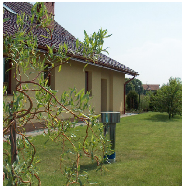
Czerpnia powietrza gruntowego wymiennika ciepła. PRO-VENT
