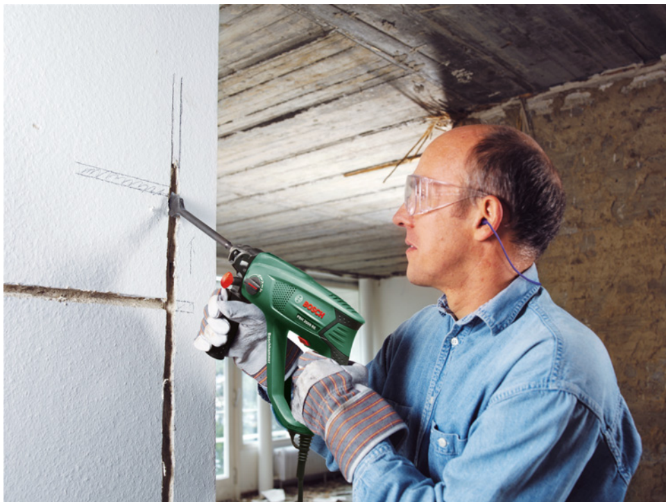
🔧 Młotowiertarka z funkcją kucia pozwala wykonać np. bruzdy ścienne. BOSCH
