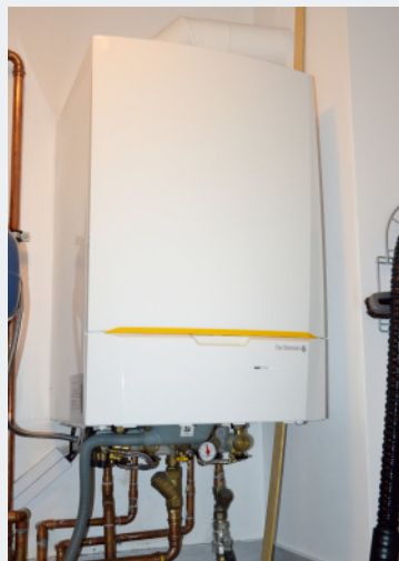
📌 Wiszący jednofunkcyjny kondensacyjny kocioł na gaz z sieci ma modulowaną moc 3,4–15,8 kW.
