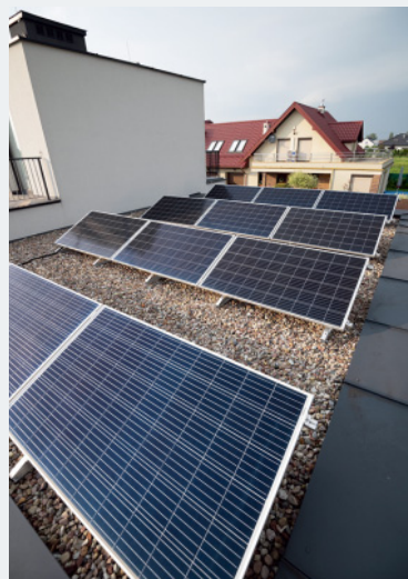
Na dachu garażu zamontowano 12 ogniw fotowoltaicznych.
