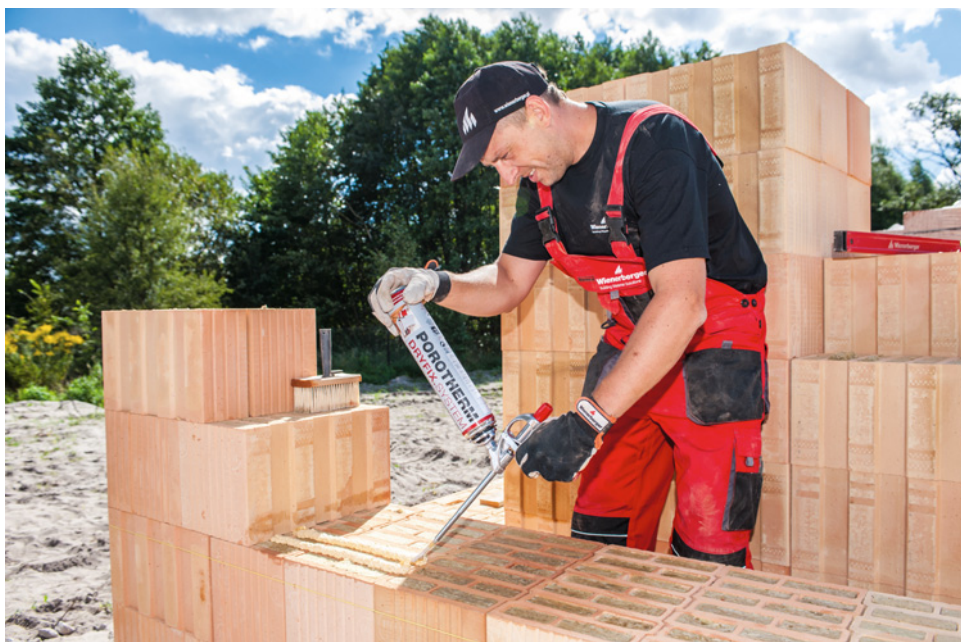
🔧 Budowanie po nowemu – pustaki z ceramiki (tu z wypełnieniem z wełny mineralnej) łączone pianą z puszk. WIENERBERGER
