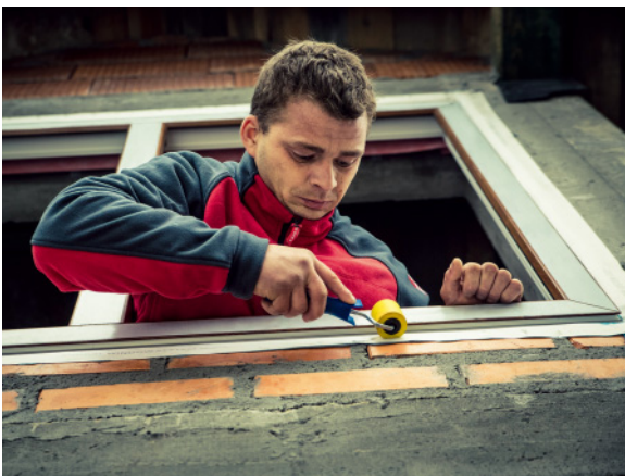
🔧 W zalecanym montażu warstwowym piankę zabezpiecza się od zewnątrz wodoodporną taśmą paroprzepuszczalną.
