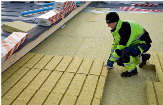
Ocieplenie dachu płaskiego wełną mineralną układaną warstwowo. PAROC
