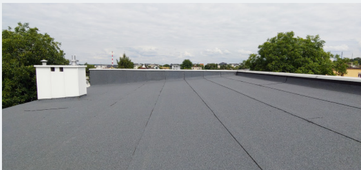
Dachy ocieplono płytami PUR i wykończono papą.
